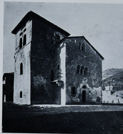
Il Cardello visto da tramontana.
