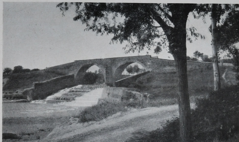
MATELLICA - IL GRANDE PONTE E LA CHIUSA SUL SAVIO, COSTRUITI NELLA METÀ DEL CINQUECENTO. (fot. A. Bandini Buti)
